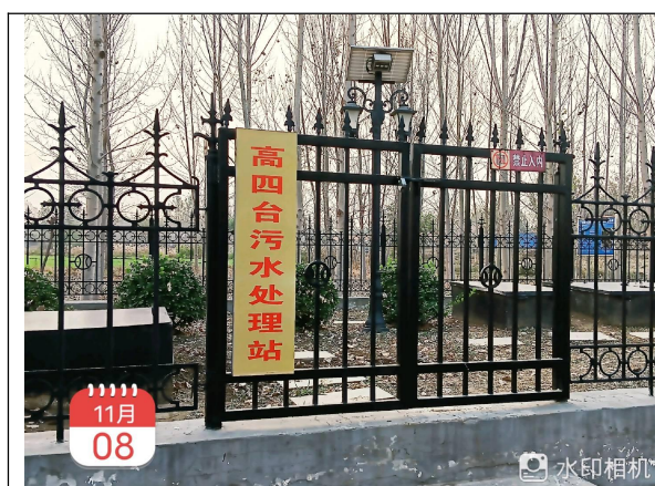
图 2-1 污水处理站勘察
