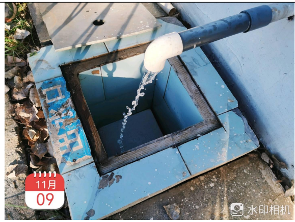
图 2-6 清水池出水勘察
