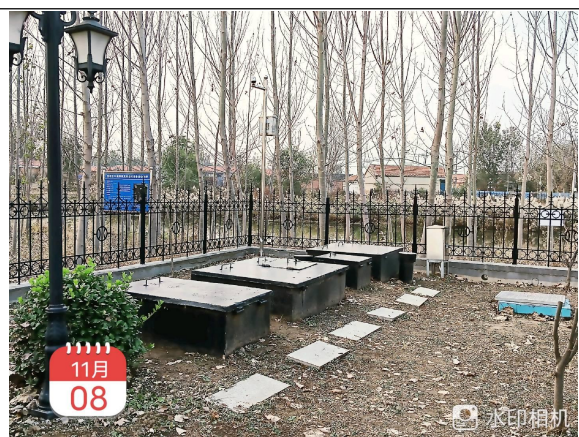
图 2-4 污水处理站勘察
