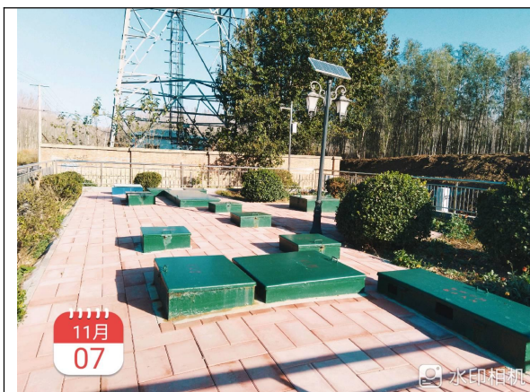
图 2-3 污水处理站勘察
