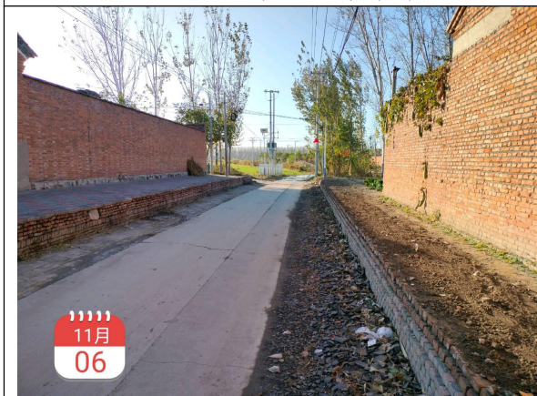
图 2-7 村内管网勘察
